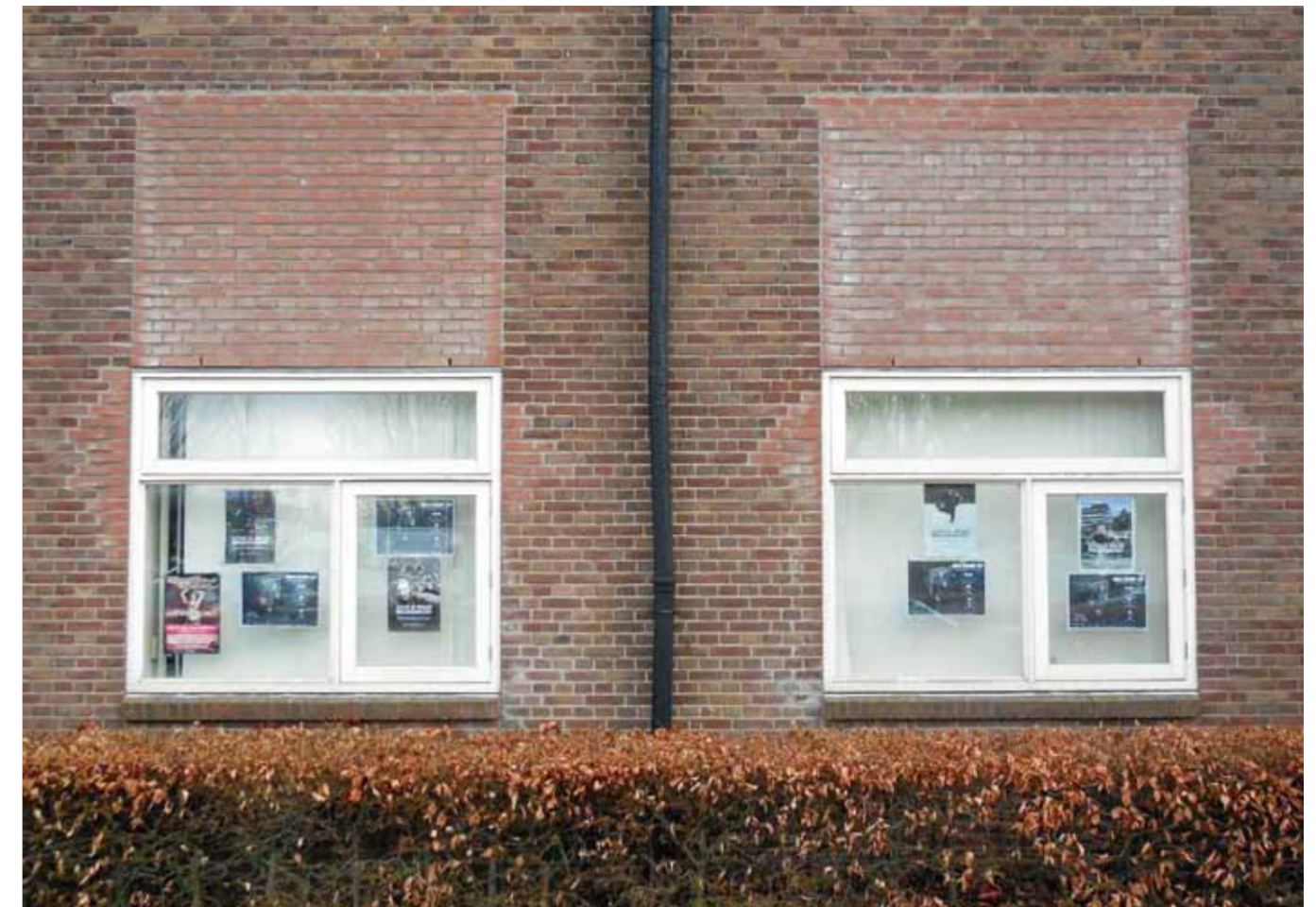
Nieuw metselwerk in de Spoorzone, Berny van de Donk
